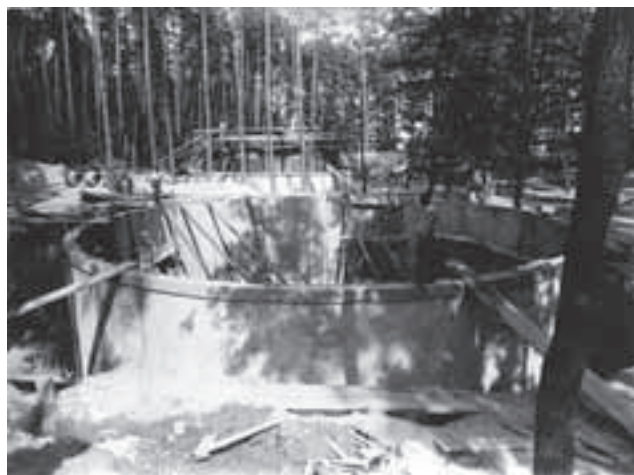
Budowa zbiorników w lesie „Zwierzyniec”, lato 1939 r. Fot. arch. A. Biernata
